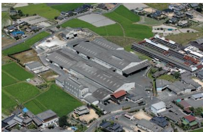
吉永工場第二製造所
