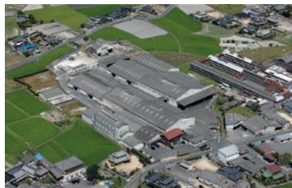
吉永工場第二製造所
