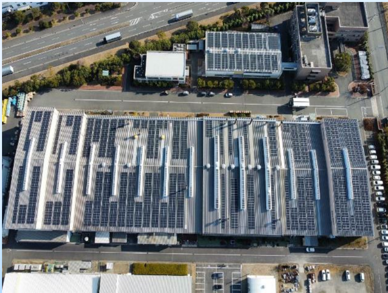
貝塚工場の太陽光発電設備 (2022年2月稼働)
