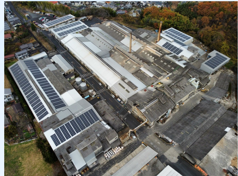
瑞浪工場の太陽光発電設備 (2022年11月稼働)
