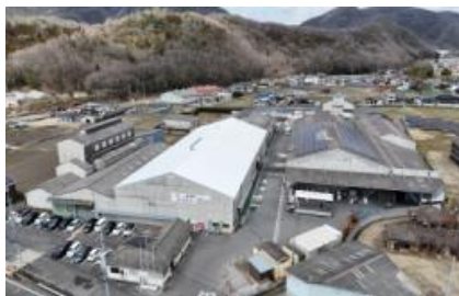
吉永工場第二製造所
