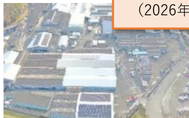
吉永工場 (第一製造所) 2023年8月稼働・2024年12月稼働、 2026年1月稼働・2026年5月稼働 発電量：716kW
