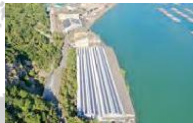
日生工場 (西工場・東工場) 2023年12月稼働・2024年12月稼働 発電量：1,171kW
