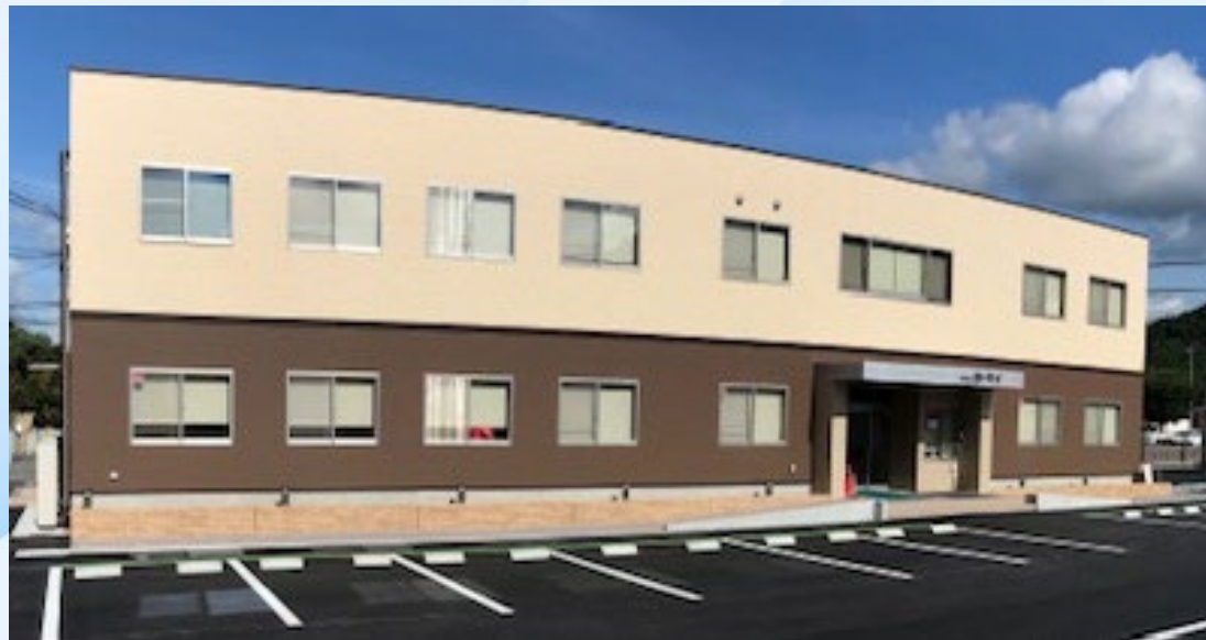
吉永工場新事務所（2022年6月完成）
