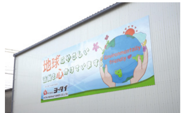
日生工場1,000Tプレス機の建屋
