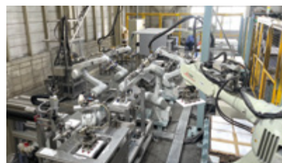
検査工程の自動化設備
