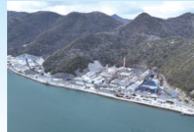
日生工場全景
